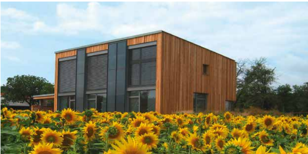
Solar house Oberduernbach, Austria
