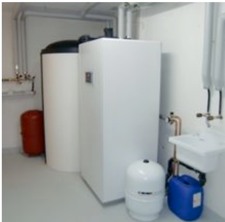
Abbildung 2: SOLAERA-Energiezentrum mit Solar-Kombispeicher als kompakte, komplett vormontierte und vollständige Wärmeversorgung
